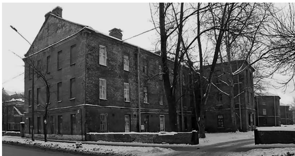
Здание Охтенского порохового завода в Санкт-Петербурге (современный вид).
